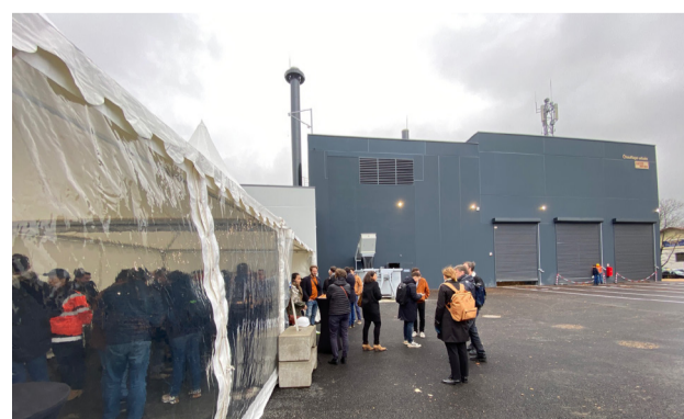
Inauguration de la chaufferie Vénissieux Sentuc.
